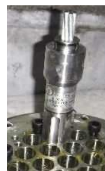
計器設置状況
