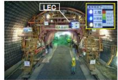
覆工コンクリート用型枠とLEC設置状況 (写真提供 (株)鴻池組様)
