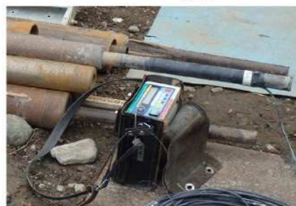
・ ボーリングロッドに接続
